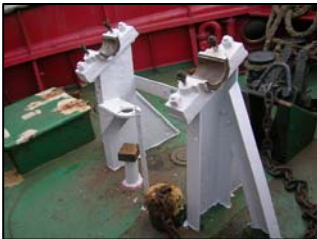
Fundamentet til ankerspillet efter rustbehandling
